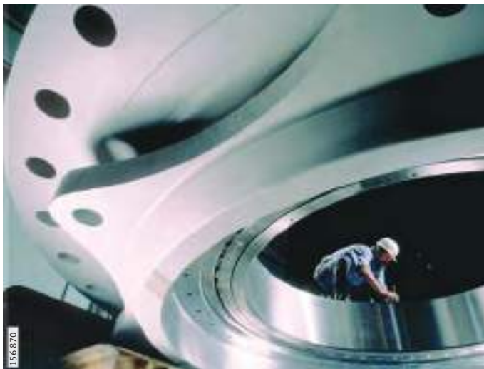
Рисунок 5 Монтаж крупногабаритного подшипника качения
