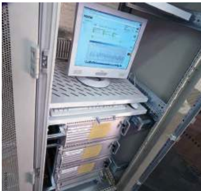
Рисунок 10 Мониторинг состояния подшипниковых опор с помощью прибора FAG VibroCheck
